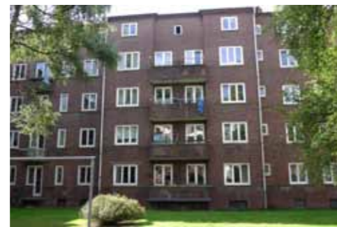
Blick auf Südteil Elisas (Elisabethgehölg). Gestaltungselemente Balkonformen, Simse, hervorspringende Gebäudeteile.
