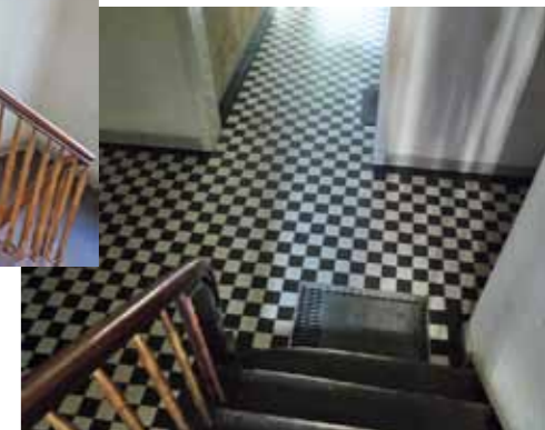
Auch typisch für die Zeit und für das Backsteinquartier die Gestaltung der Treppenhäuser mit den schwarz-weißen Fliesen, gedrehten Geländern.
