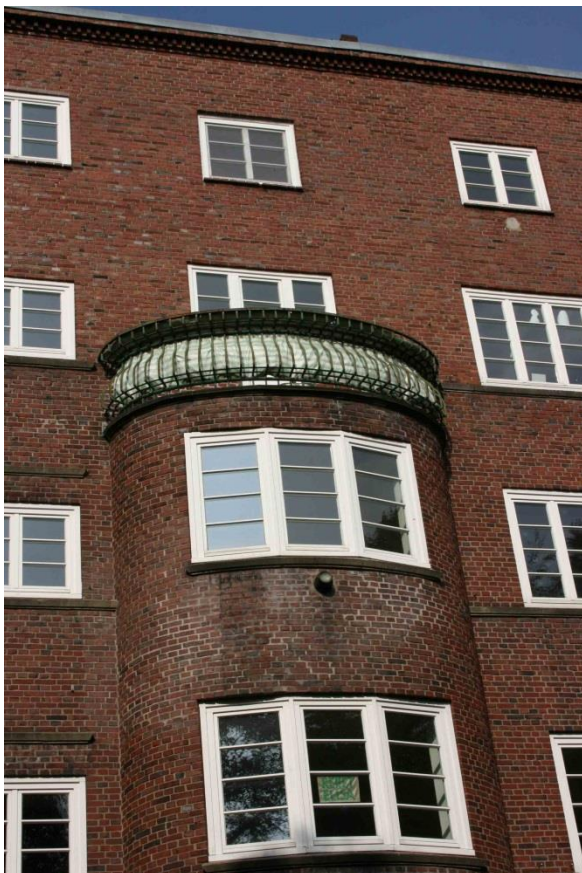
Abb. 2. Halbrunder Erker mit Balkon und bauzeitlichem Gitter (links). Abb. 3. (rechts) Blick in eines der Treppenhäuser mit Buchenholzgeländer, historischen Bodenfliesen und Linoleumbelag auf der Treppe. Fotos: Dahms 30.09.2014.
