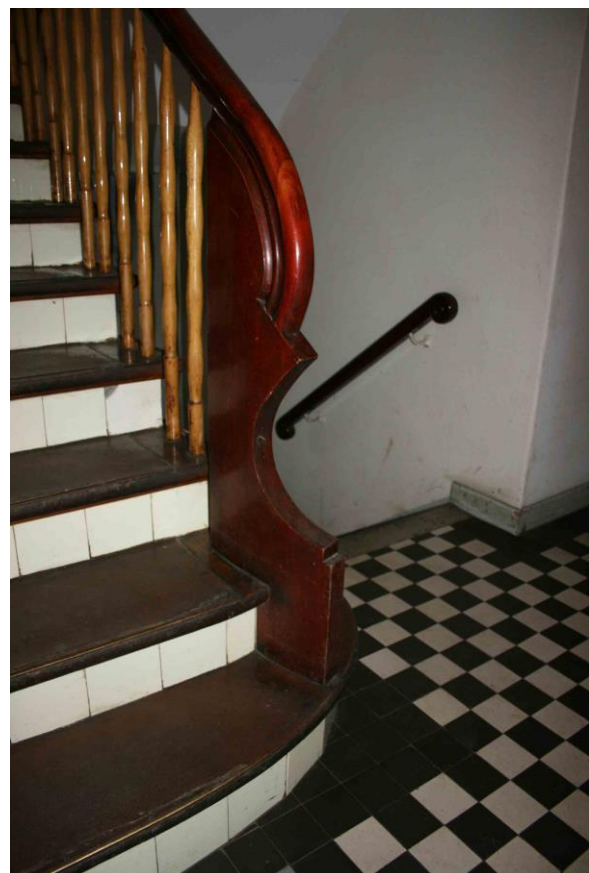
Abb. 2. Halbrunder Erker mit Balkon und bauzeitlichem Gitter (links). Abb. 3. (rechts) Blick in eines der Treppenhäuser mit Buchenholzgeländer, historischen Bodenfliesen und Linoleumbelag auf der Treppe. Fotos: Dahms 30.09.2014.
